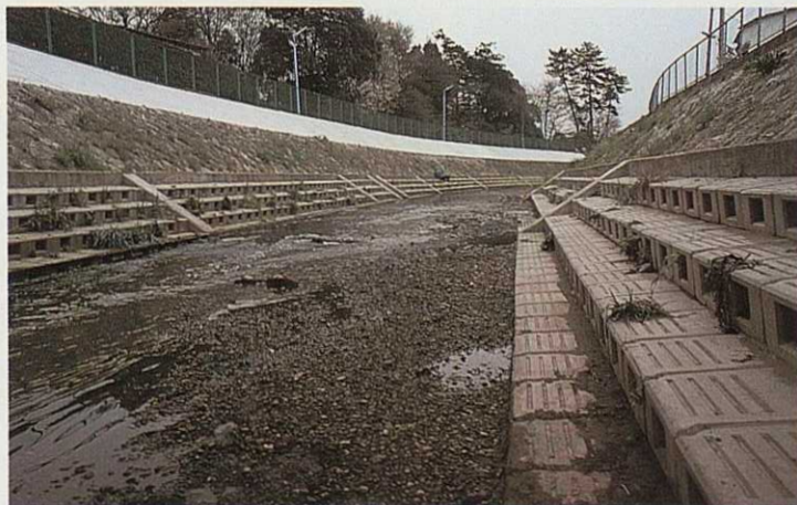
69 善福寺川宮下橋下流魚巢ブロック
