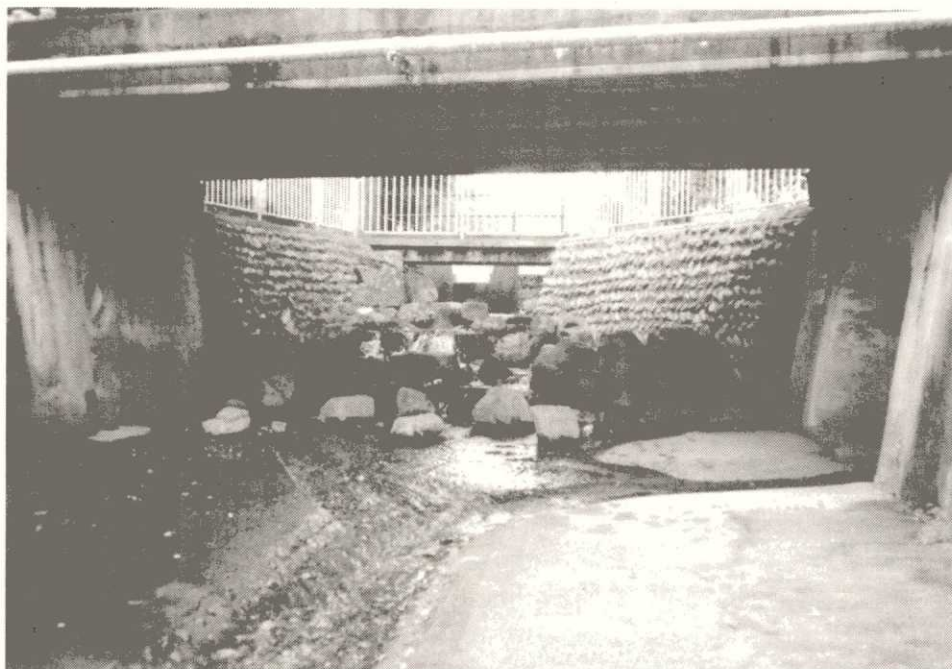
写真-3.2(1) 善福寺川 Z-1 美濃山橋 (上流側) 平成12年10月16日
