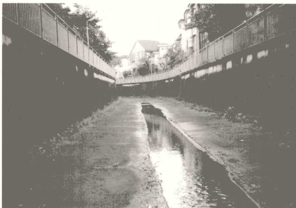
写真-3.2(2) 善福寺川 Z-1 美濃山橋 (下流側) 平成12年10月16日
