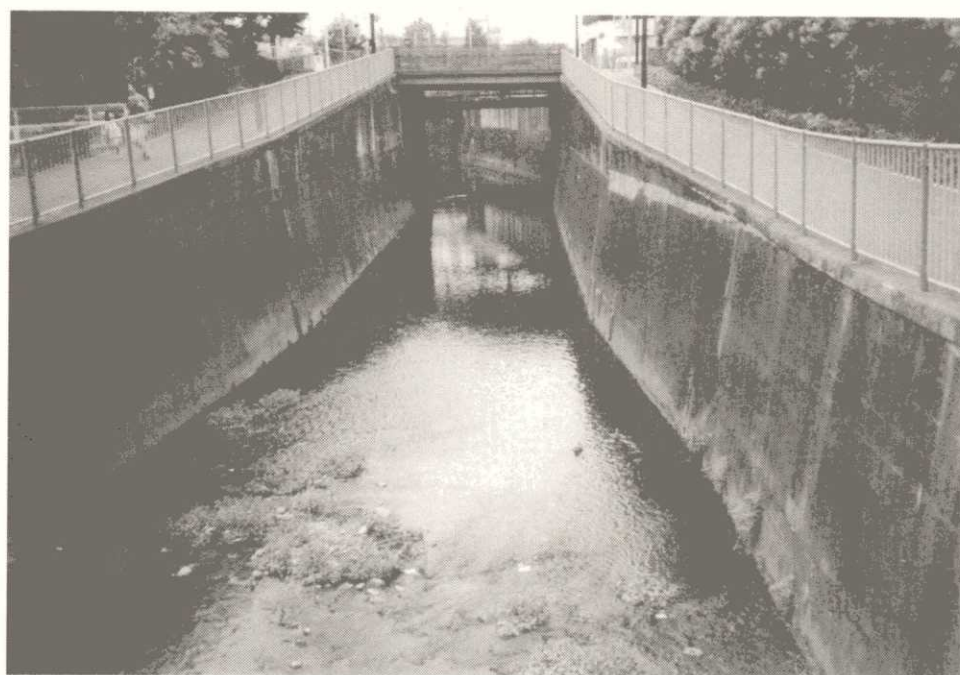
写真-3.14(2) 神田川 K-4 蔵下橋 (下流側) 平成12年6月22日
