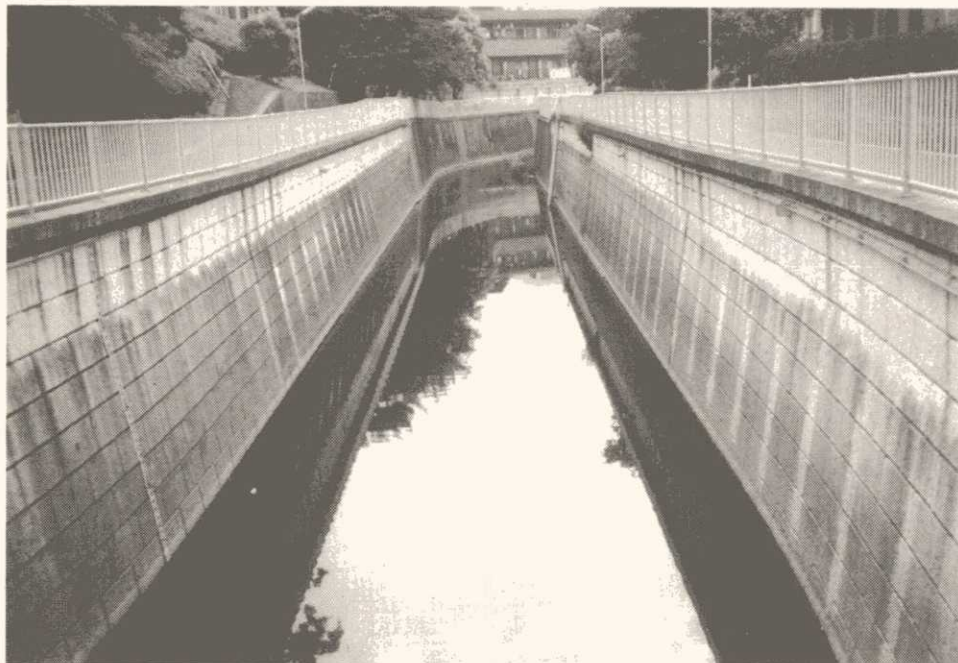
写真-3.15(1) 神田川 K-5 方南第一橋 (上流側) 平成12年6月22日
