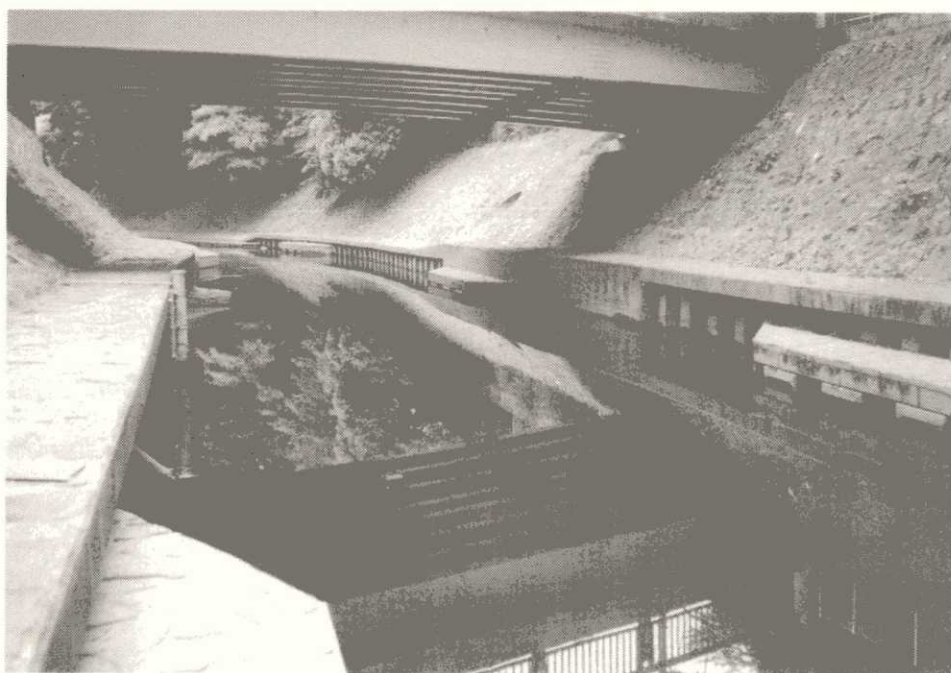
写真-3.9(2) 善福寺川 Z-8 宮下橋 (下流側) 平成12年6月21日
