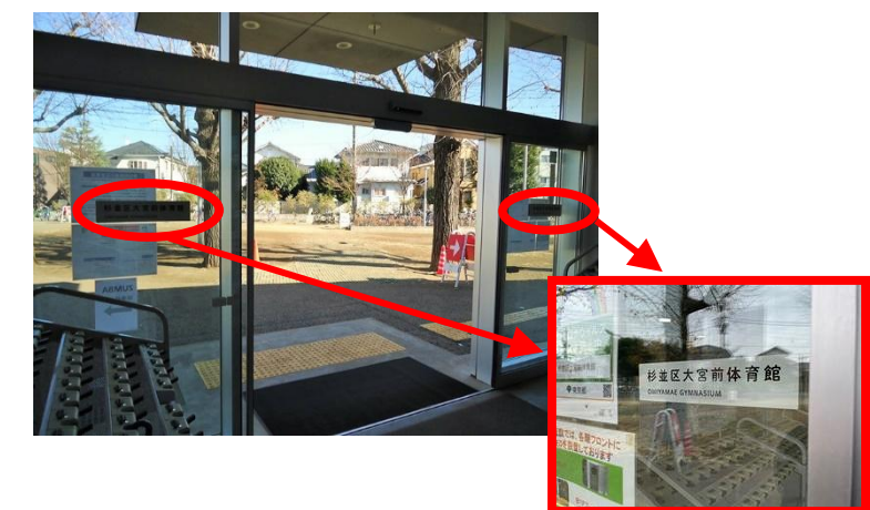
③メインエントランス 自動ドア両扉両面 (4 か所)
