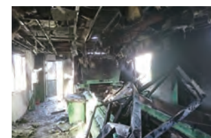
リサイクル工場の火災写真(例) 出典: 日本容器包装リサイクル協会
