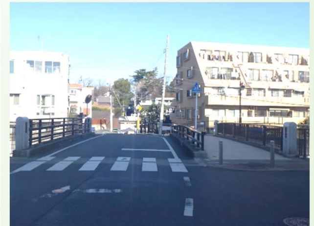
河川整備事業による橋梁拡幅 (堀ノ内一丁目 本村橋)
