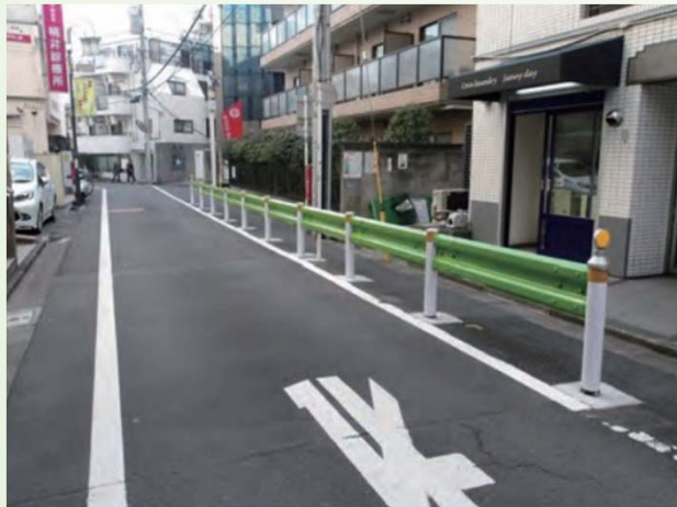
防護柵の設置
