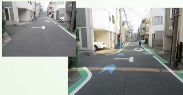
片側から両側への路側帯設置
