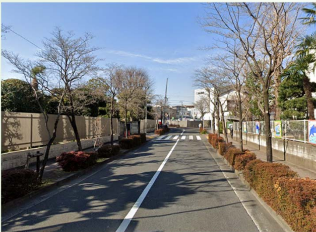
幅員12mの主要生活道路 (和田一丁目)
