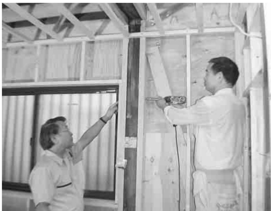
▲斜めに角材(スジカキ)を入れ、弱い部分の柱と壁を補強しています
