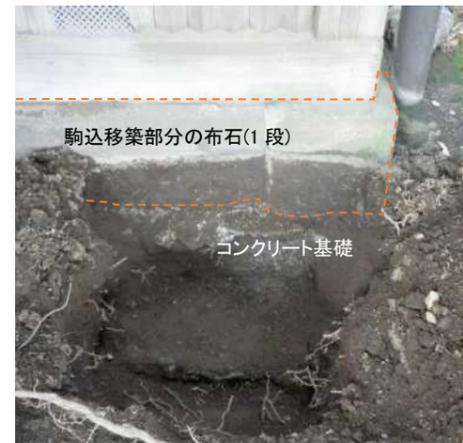
駒込移築部分「次の間」基礎状況 布石1段の下に移築前と同じようなコンクリート基礎が確認される
