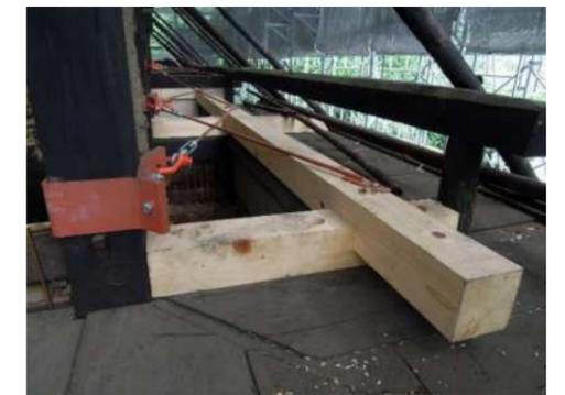
小屋裏の水平ブレースによる補強
