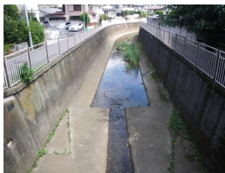
写真Ⅲ-30 コンクリート護岸
