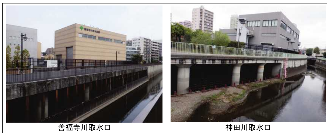
写真 III-11 神田川・環状七号線地下調整池への取水口
