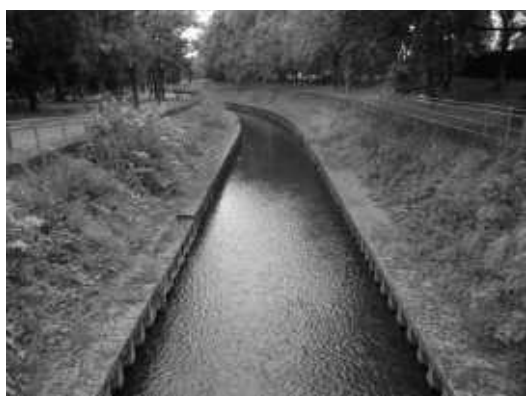
緩傾斜護岸 (Z5 成田上橋)
