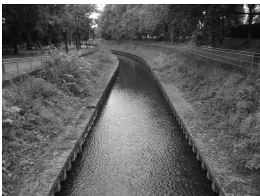
緩傾斜護岸 (Z5 成田上橋)
