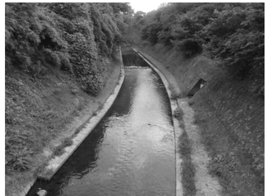
樹林と隣接した護岸 (Z5 宿山橋)
