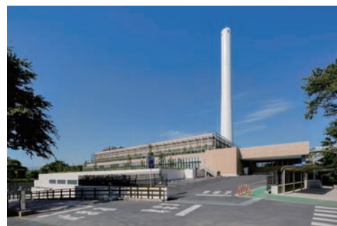
すぎなみせいそう 杉並清掃工場
