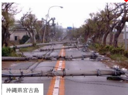
電柱の倒壊に伴い垂れ下がった電線 ↓
