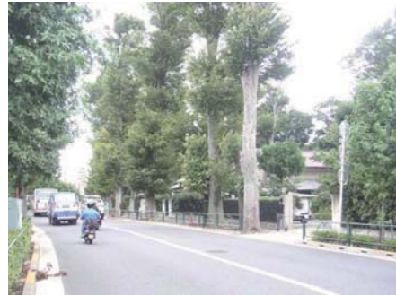
既存ケヤキ並木を保全した拡幅整備 (五日市街道)
