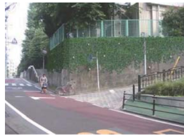
コンクリート擁壁につたを這わす（加工）
