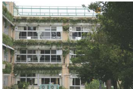
外壁改修とともに実施した壁面緑化 (杉並第七小学校)
