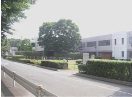
道路沿いのオープンスペース (井草地域区民センター)
