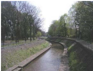
石張りの傾斜護岸 (善福寺川成田上橋付近)
