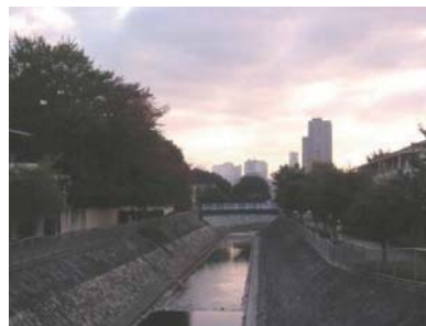
副都心を望む (善福寺川大松橋)
