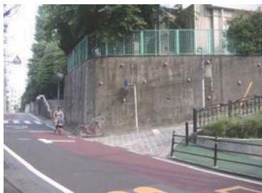
高く垂直のコンクリート擁壁
