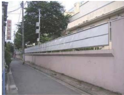
アクリル板の目隠しフェンス
