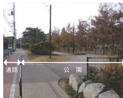
歩道部の舗装材を入口内部にも敷設 (柏の宮公園)
