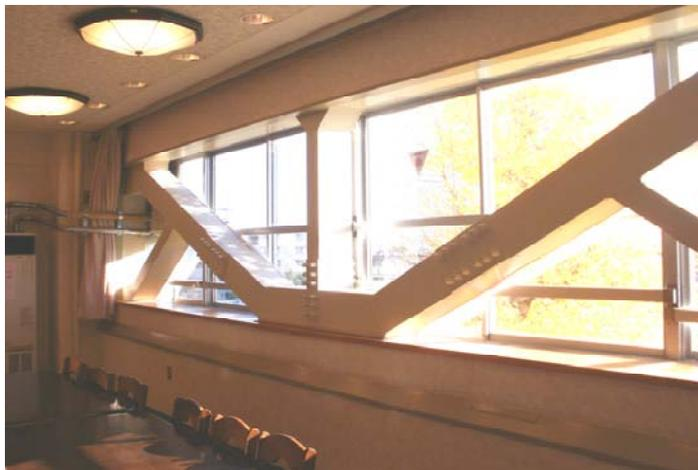
高井戸東小学校耐震補強(ランチルーム窓側部分の耐震補強鉄骨ブレース 筋交い)
