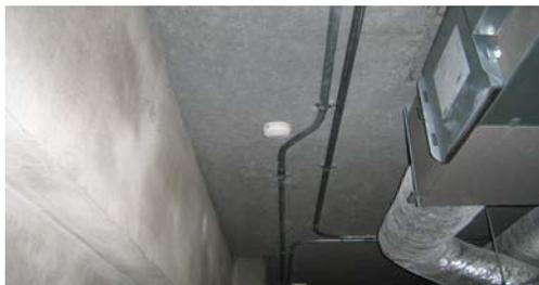
除去前の吹付けアスベストの状況(左写真:空調機械室天井)
