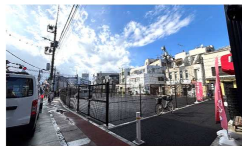
仮整備後の様子
