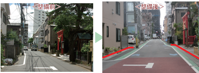
▲建物の建替えに合わせ古い塀を作り直し、道路を拡幅整備
