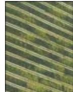
校舎東西の壁面に壁面緑化を行い、壁面の遮熱性能を高める。同時に東側は小さな中庭の背景として、西側は近隣に対する配慮として機能する。
