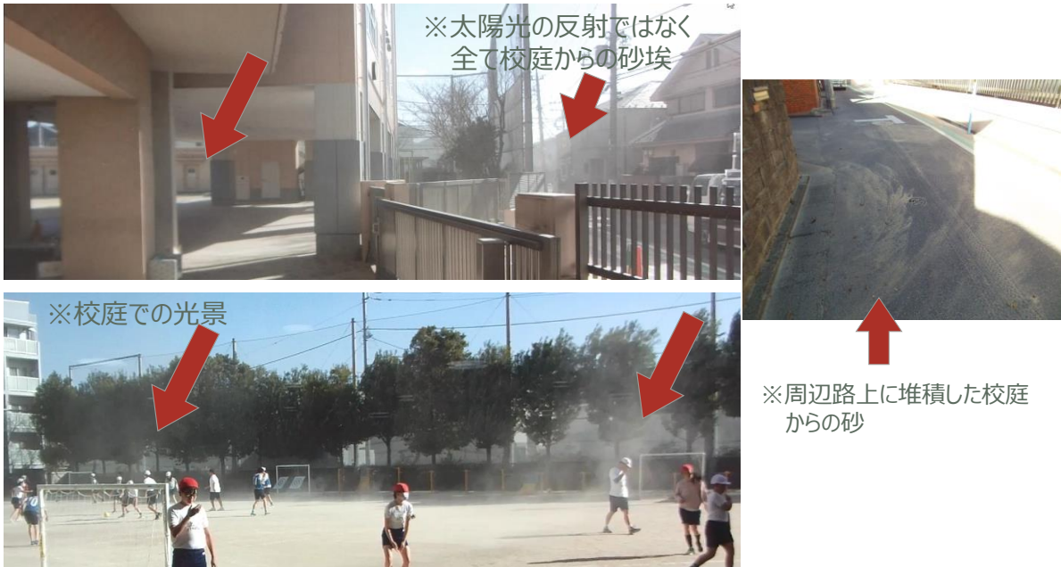
【土系舗装の砂塵事例】
