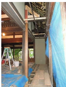
縁側などでの添え柱補強
