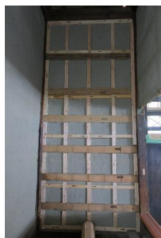
片面土壁、片面合板
