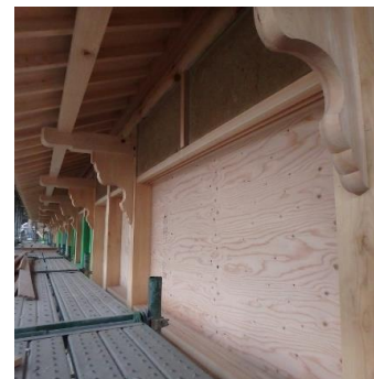
板壁部分の構造合板下地
