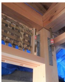
土壁内の耐震補強金物
