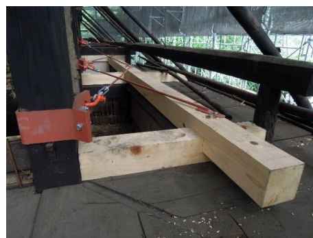
小屋裏の水平ブレースによる補強
